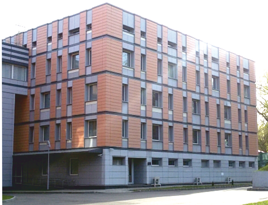
Здание Московской лаборатории, расположенное по адресу: г. Москва, Елизаветинский переулок, д. 10
